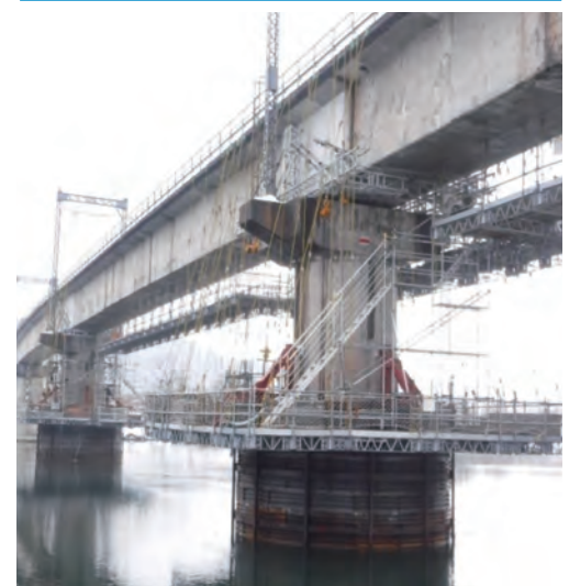
2020年度施工 橋脚耐震補強工事(2基同時施工)
