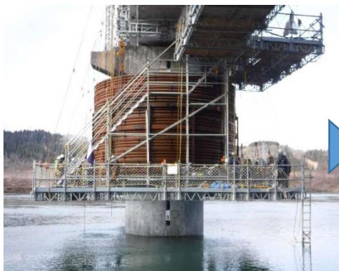
仮締切り設備（ライナープレート）組立
