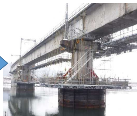
仮締切り設備（ライナープレート）沈設完了
