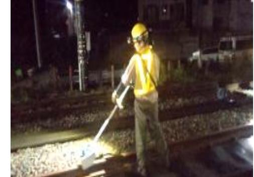
バッテリー式レール研磨機
