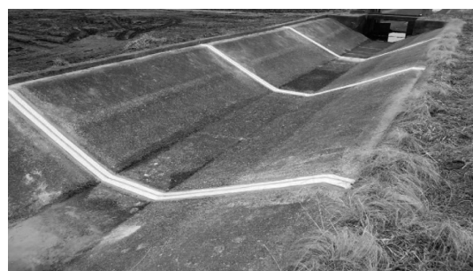
写真-1 コンクリート用水路目地部への施工例
